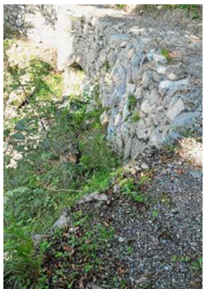
Handwerkskunst beim Atschabach: Die Stützmauern wurden wieder aufgemauert.
